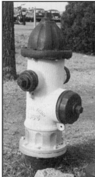
Hidran barrel-kering yang umum
