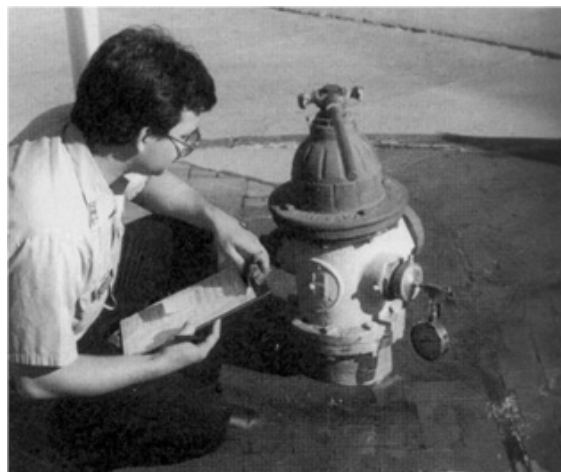
Tekanan sisa pada hidran diukur ketika air dikeluarkan dari hidran yang lain
