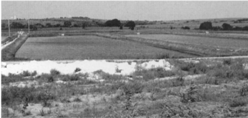
Tandon air terbuka biasanya berada di lokasi reaktor pengolahan air dan dapat digunakan sebagai sumber air dalam operasi penanggulangan kebakaran
