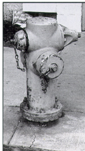
Hidran barrel-basah yang umum.
